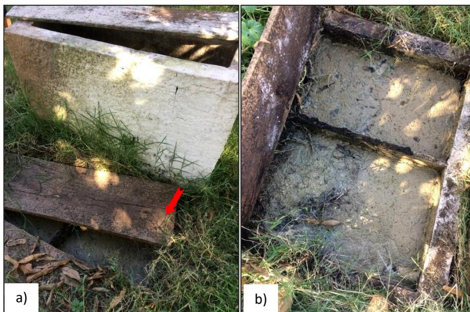
**FIGURA 3** – A seta indica a tubulação que interliga as unidades I e II; b) Vista superior unidade II.
